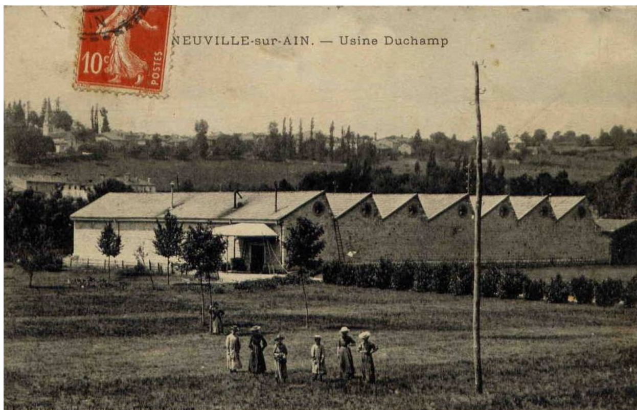
Au premier plan à droite le support bois de la ligne 3000 volts
