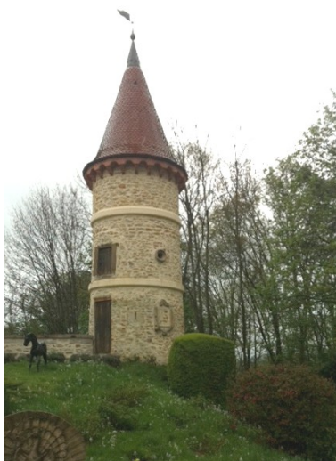
Tour d'angle nord-ouest dite « le pigeonnier » – Photo A. Allano
