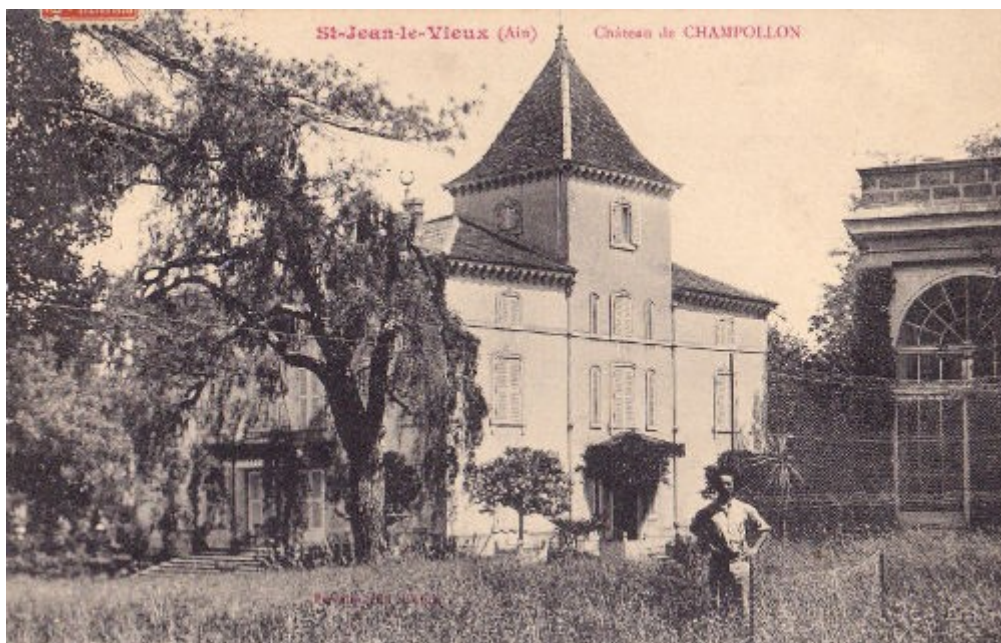
Façade Sud-Est et serre début XX e siècle – Collection J. Grimbot
