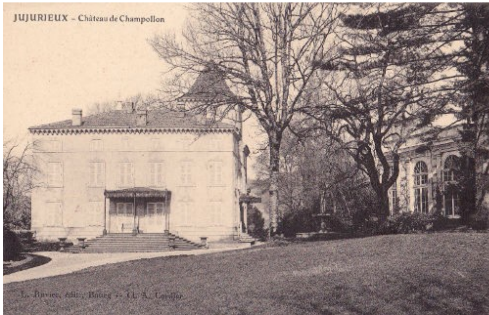
Façade Sud-Ouest et serre début XX e siècle – Collection J. Grimbot
