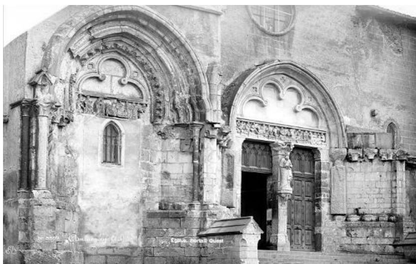
État du parvis en 1881- Photo Émeric Mieusement
