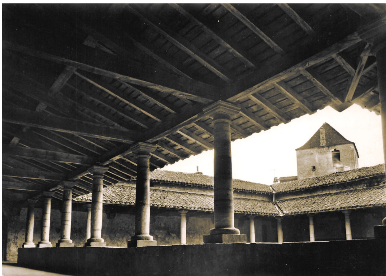
Charpente et voligeage des galeries du cloître - Coll. particulière
