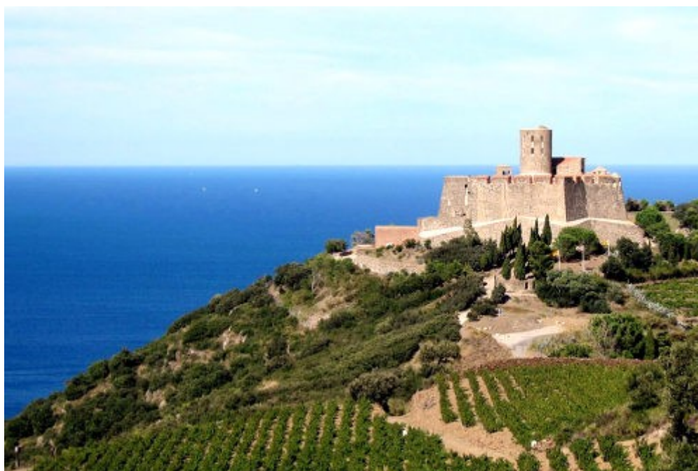
Fort Saint Elme à Collioure - Collection particulière
